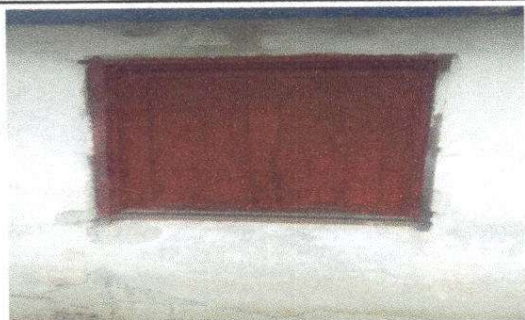
Foto 8: Sustitucion de ventana de madera por metal mas vidrio
