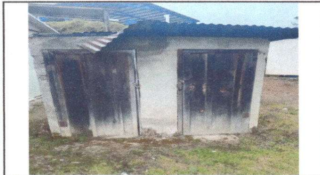
Foto 3: SUSTITUCION DE PUERTAS EN SERVICIOS SANITARIOS
