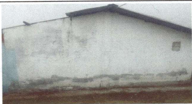
Foto7: Pintura en muro exterior
