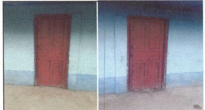
Foto 2: SUSTITUCION DE PUERTAS
