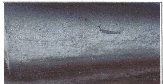
FOTO 6. REPELLO EN MURO
